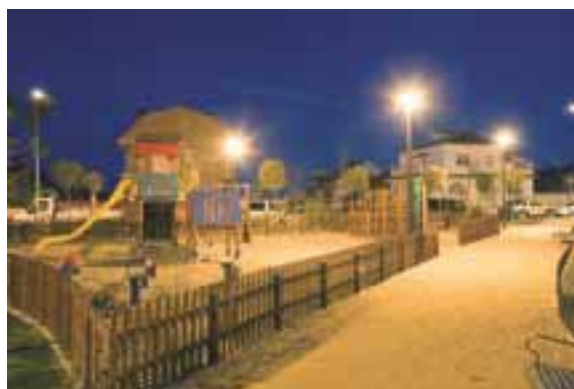
Prima: lampada gialla al sodio ad alta pressione
