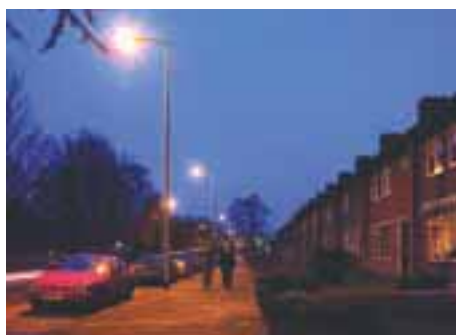
Prima: utilizzo di lampade al sodio ad alta pressione Eindhoven, Paesi Bassi
